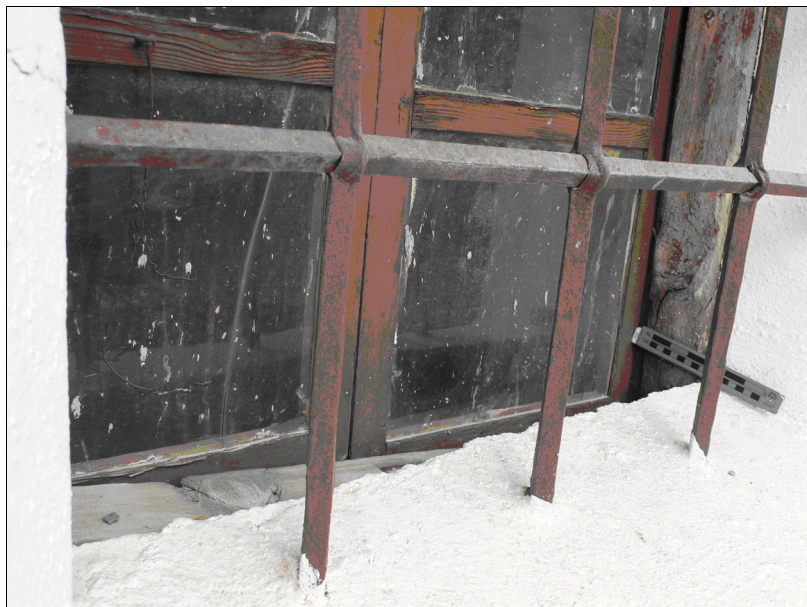
Figura 7: Esempio di disassamento di un infisso della chiesa di Thures. Figure 7: Window shift example on the Thures Church.
