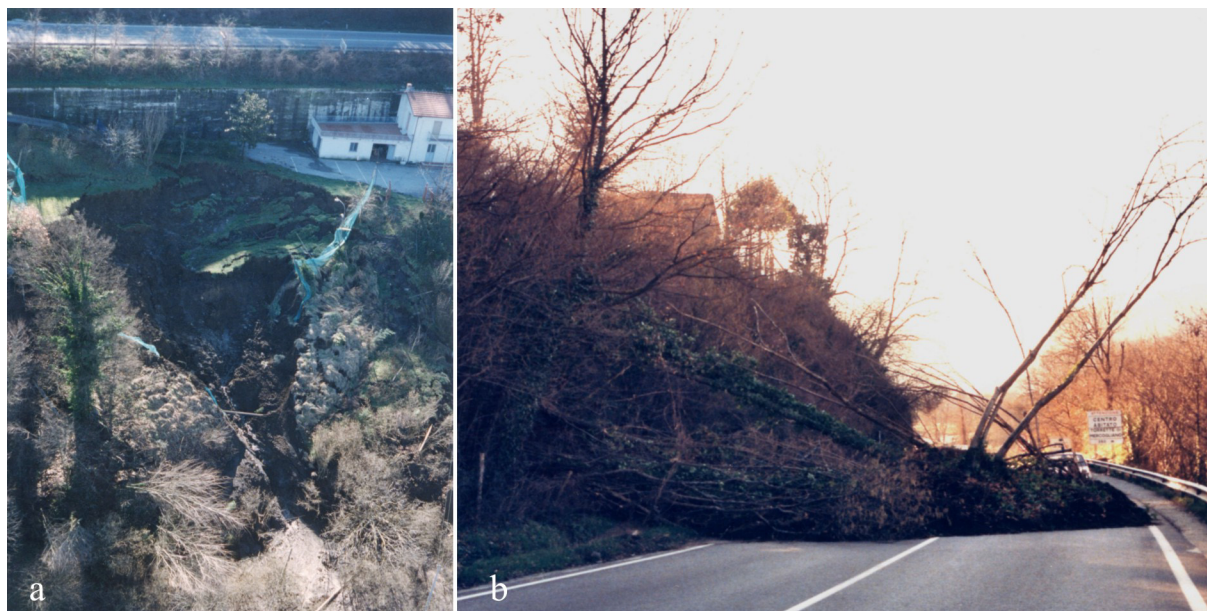
Figura 5: Le due frane ubicate a monte (a) e a valle (b) della variante SS 7 bis di Avellino. Figure 5: The two landslides located down (a) and up (b) to the SS 7 bis of the Avellino.
