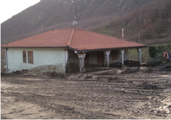
Figura 9: Le impronte di impatto rinvenute lungo il muro di una abitazione interessata dalla colata rapida (Bosco dè Preti). Figure 9: The clearly evident scars of the landslide observed along the wall of the house (Bosco dè Preti).
