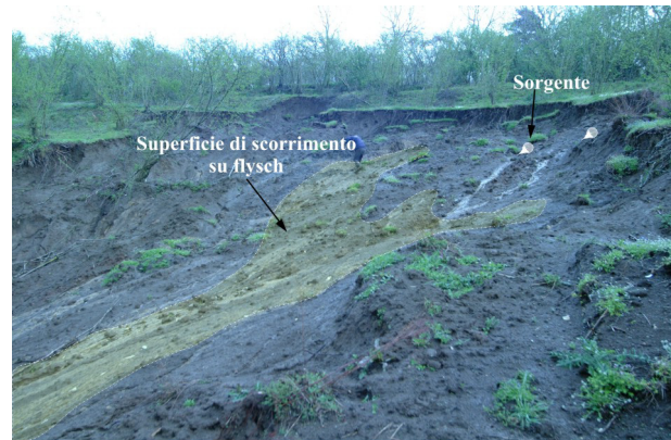
Figura 12: Area sorgente della colata rapida in località Pozzillo a Contrada; si può notare il substrato marnoso-argilloso in affioramento e alcune sorgenti.
