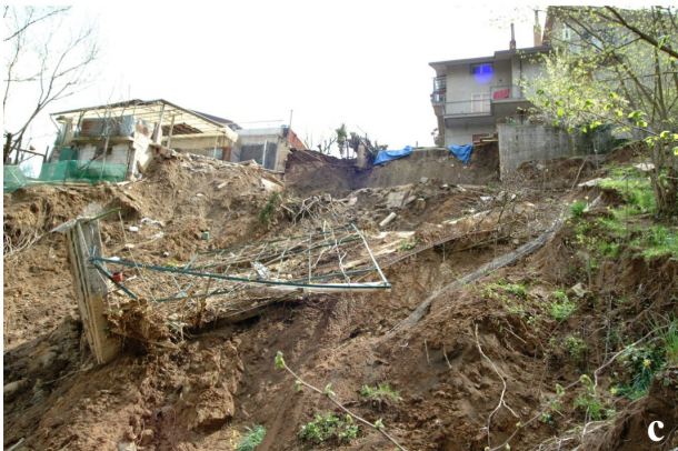
Figura 10: Alcune delle frane in località Cesine (n° 14 e 15) che hanno danneggiato aree agricole (a e b) ed alcune abitazioni (c). Figure 10: Some of the flowslides occurred at Cesine (n° 14 and 15) caused serious damages to cultures (a e b) and houses (c).
