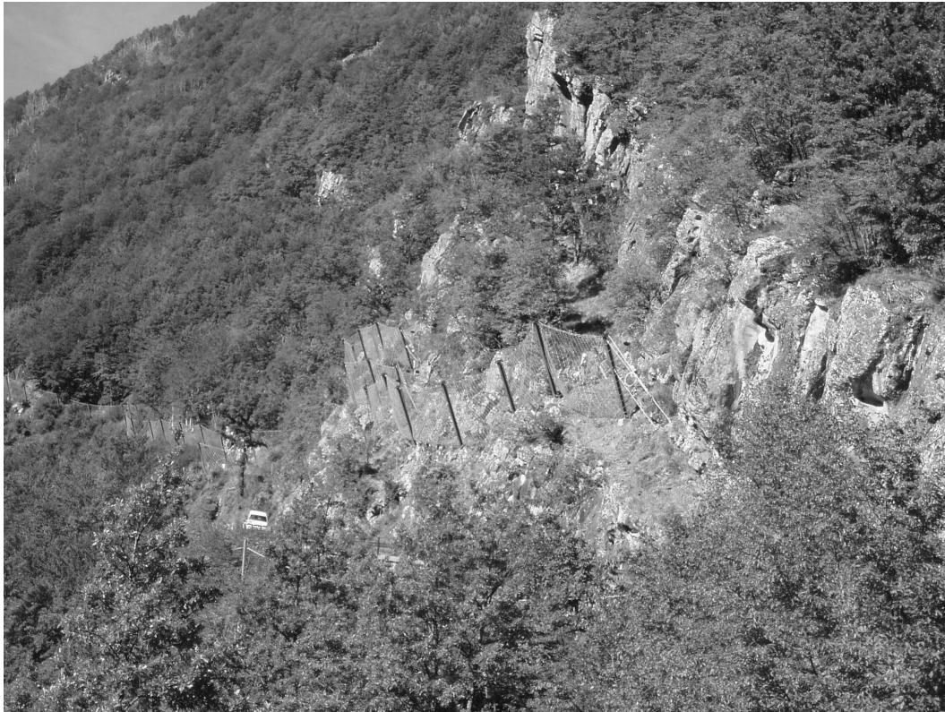
Fig. 9 – Panoramica di una linea di barriera paramassi ad elementi impostata lungo un gradino morfologico della parete rocciosa Fig. 9 – Panoramic view of a rock fall barrier line set up on a morphological step of the rock slope
