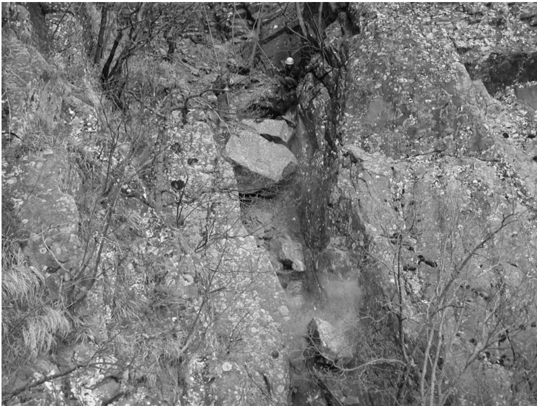
Fig. 7 – Roccatori impegnanti nelle operazioni di pulizia e disaggio di massi pericolanti Fig. 7 – High scalers suspended on rope and belt while removing loose rock
