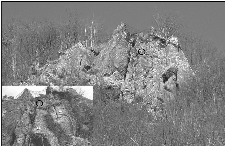
Fig. 10 – Pannelli di rete ad elevata resistenza in una porzione del versante posta lungo la linea di crinale (si veda l'ubicazione in Fig. 7). Vistose fratture sub-verticali caratterizzano tale porzione. Il riquadro costituisce una visione ravvicinata della parete rocciosa bonificata e consolidata. I cerchi indicano lo stesso punto per un confronto fra le due diverse inquadrature
