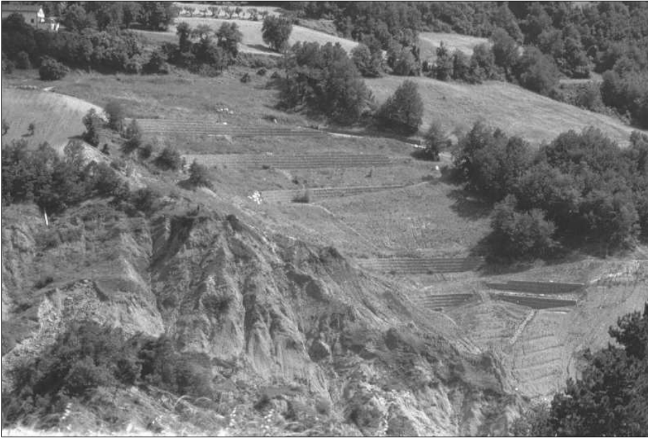
Fig. 17 – Panoramica delle opere realizzate nel 2002
