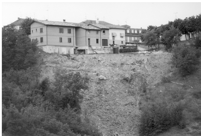
Fig. 8 – Panoramica e particolare di alcuni crolli causati dalla regressione della testata della vallecchia calanchiva n° 1 (cf. Fig. 9) alla periferia nord del capoluogo di Baiso
