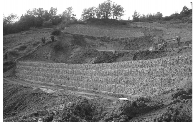
Fig. 1 – Gabbionata a quattro ordini in corso di realizzazione nel 2002 sul calanco in località Giorgella, in Comune di Baiso (Reggio Emilia) (Foto S. Patrizi)
