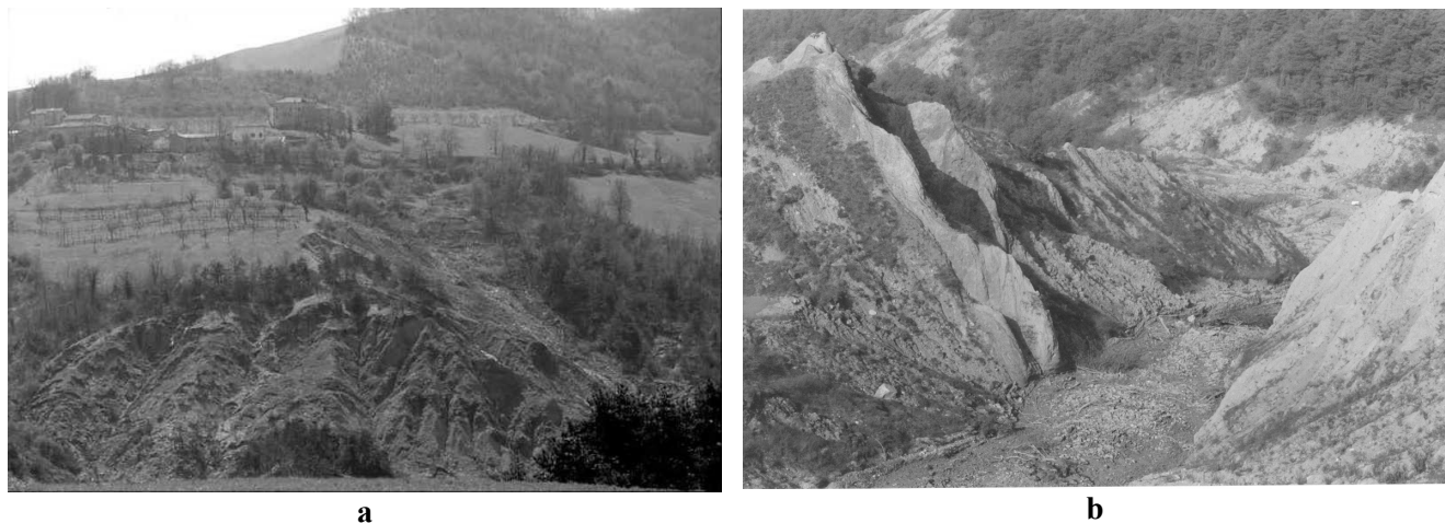
Fig. 16 – Dissesto presente sulla periferia nord dell’abitato di Cassinago di Baiso (anno 1995): a) vista panoramica da valle; b) particolare visto da monte
