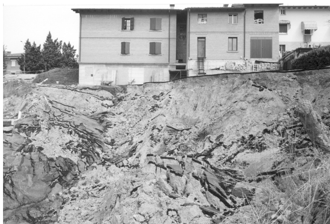
Fig. 8 – Panoramica e particolare di alcuni crolli causati dalla regressione della testata della vallecchia calanchiva n° 1 (cf. Fig. 9) alla periferia nord del capoluogo di Baiso
