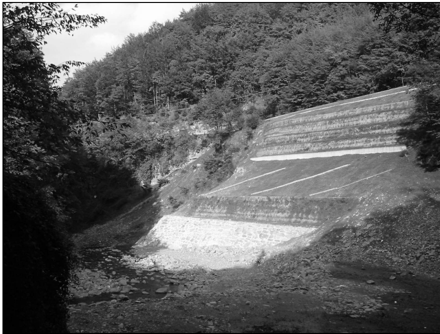
Fig. 10 - Aspetto del versante oggetto di intervento al 17 settembre 2003. Le talee non hanno ancora completato l'azione di copertura delle terre rinforzate ma si nota, a distanza di un anno dal termine dei lavori, un'importante crescita vegetativa delle specie arbustive che avranno il compito di creare il mascheramento principale
