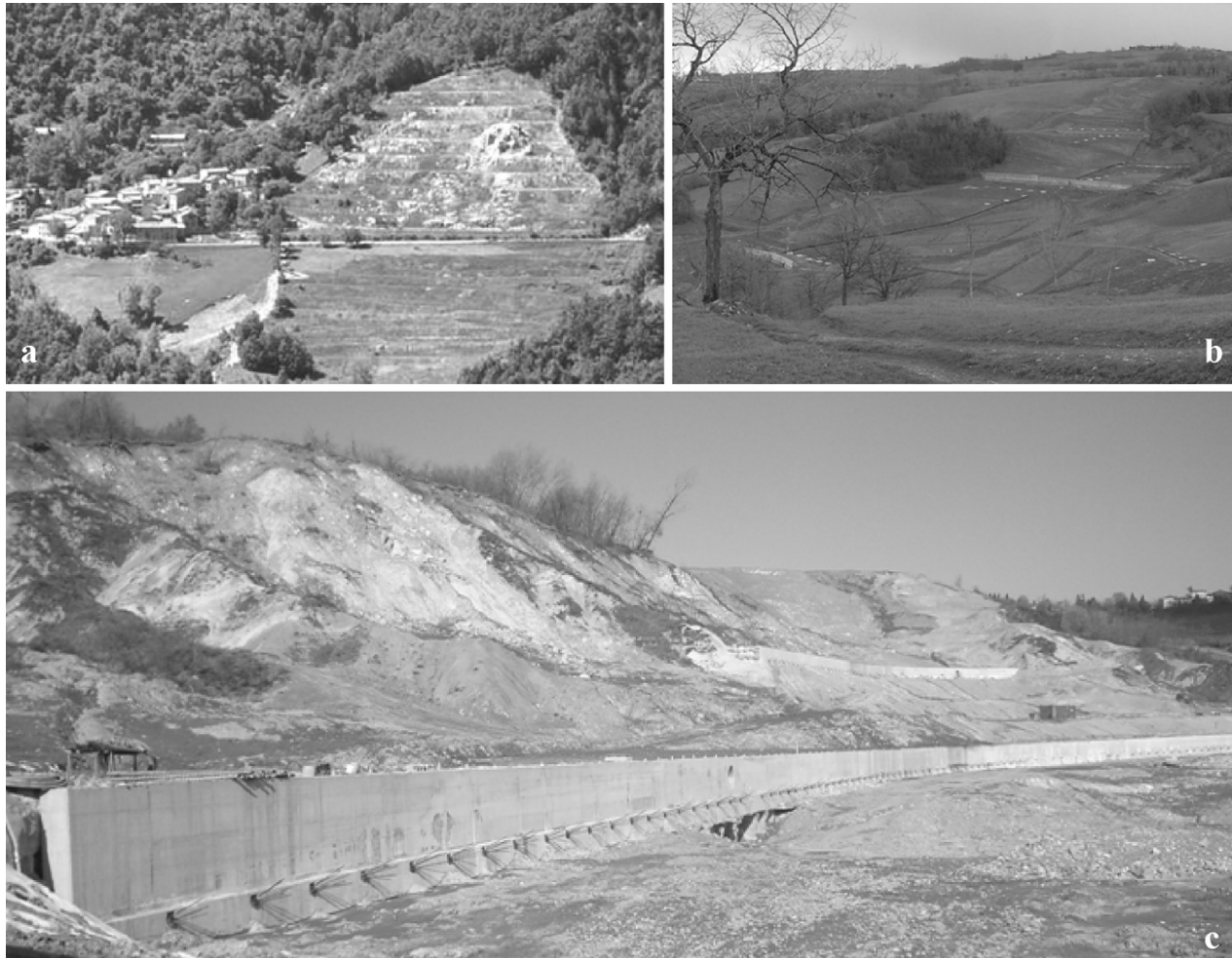
Fig. 8 – Frane consolidate: a) frana di Acquabona dopo la riprofilatura del versante e la quasi completa rivegetazione delle scarpate; b) frana di Magliatica. Si osservano le paratie e gli schemi di pozzi drenanti nella parte alta della frana; c) frana di Ca' Lita. Paratie nella scarpata secondaria
