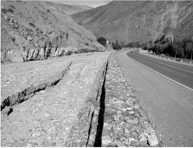
Fig. 6 – La Ruta Nacional 52 che collega l'Argentina con il Cile, nel tratto che corre lungo la Quebrada de Purmamarca è stata costruita interamente all'interno dell'alveo del Rio omonimo Ruta Nacional No. 52, joining Argentina with Chile. The stretch of the road along Quebrada de Purmamarca occupies a large portion of the riverbed's cross-section
