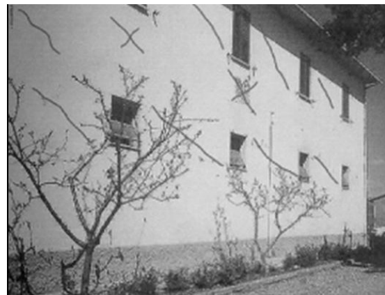
Fig. 4: Effetti sul corpo centrale in area Sugherelle – Piancastagnaio (SI): le lesioni ad "x" implicano effetti dell'VIII-IX grado della scala MCS
