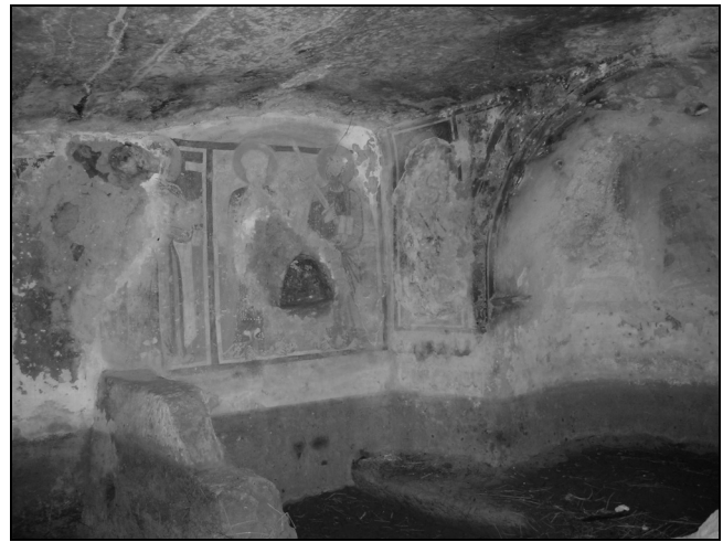
Fig. 6 – Chiesa di S. Procopio in Monopoli (BA) – Fenomeni di degrado che interessano gli affreschi Degradation phenomena affecting frescoes
