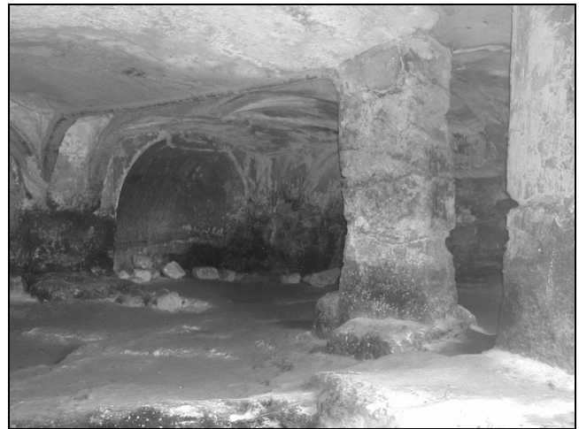
Figura 4. Chiesa di S. Angelo di Casalrotto in Mottola (TA) – Vista generale della cripta superiore con fenomeni di degrado di tipo fisico, chimico e biologico
