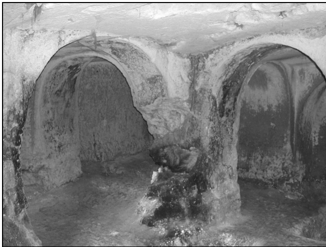
Figura 3. Chiesa di S. Angelo di Casalrotto in Mottola (TA) – Cripta inferiore, degrado dovuto a fenomeni di tipo chimico e biologico
