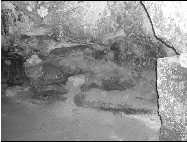
Figura 2. Chiesa di S. Angelo di Casalrotto in Mottola (TA) – Degrado condizionato da un giunto di stratificazione Degradation phenomenon conditioned by a stratification joint
