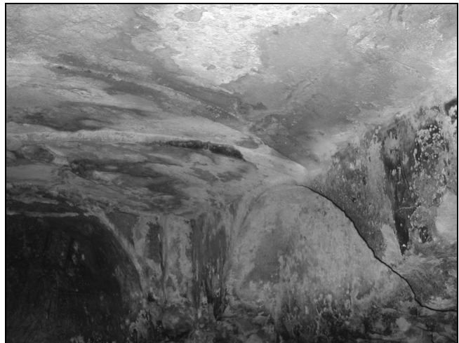
Fig. 5 – Chiesa di S. Angelo di Casalrotto [Mottola (TA)] - Cripta superiore con fenomeni di degrado di tipo fisico, chimico e biologico
