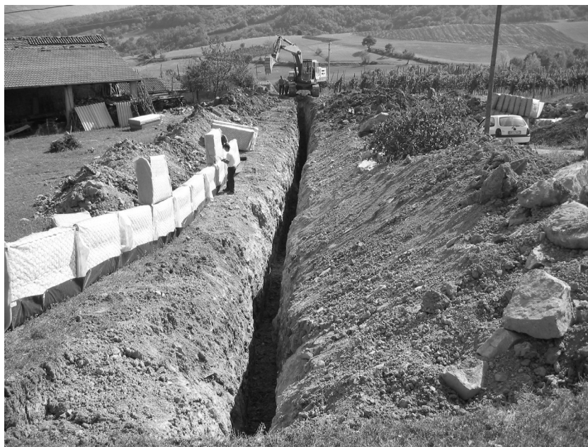
Fig. 7 Particolare drenaggio B: allineamento pannelli drenanti tipo Gabbiodren con camini orizzontali Drain details B. alignment of Gabbiodren draining panels with horizontal draining wells
