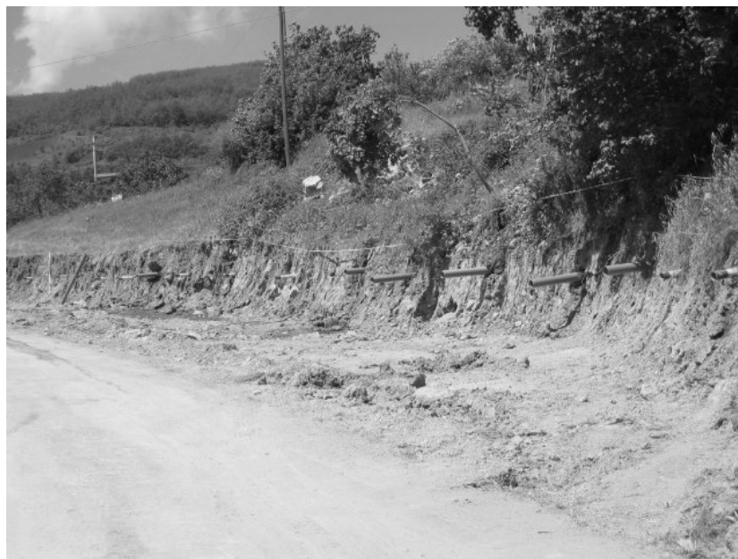
Fig. 3 Zona collettamento dreni sub-orizzontali con i pannelli drenanti, prima del ripristino finale Connection area among sub-horizontal drains and draining panels before final reconstruction
