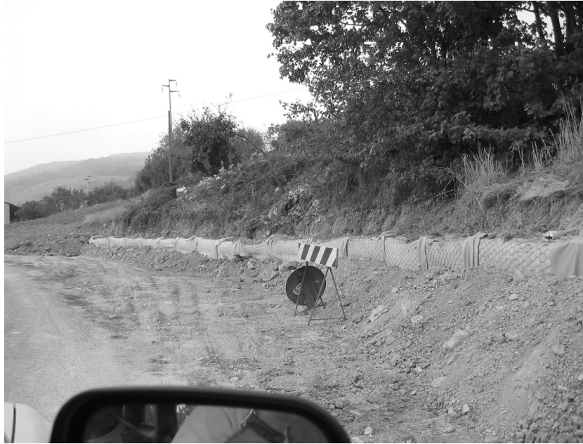
Fig. 4 Zona collettamento dreni sub-orizzontali con i pannelli drenanti, prima del ripristino finale Connection area among sub-horizontal drains and draining panels before final reconstruction
