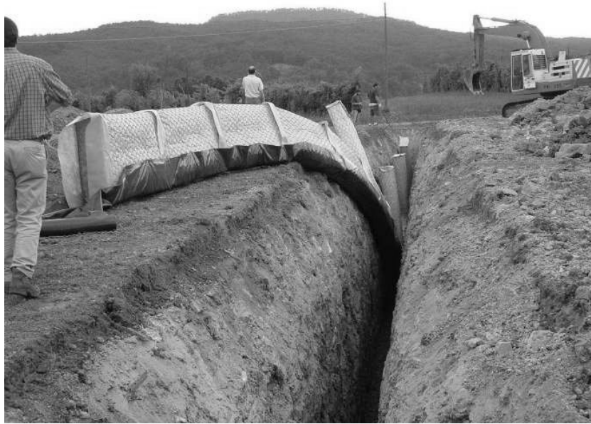
Fig. 8 Particolare drenaggio A: pannelli drenanti tipo Gabbiodren con camini verticali, assemblati e calati nello scavo a sezione obbligata Drain details A: Gabbiodren draining panels with vertical draining wells; aligned and laied inside a reduced section trench
