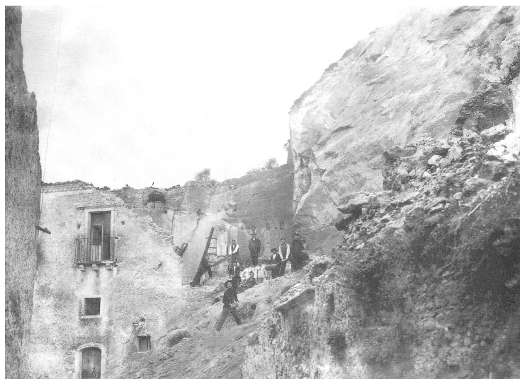
Fig. 7 e 8 – Fig. 7: Il crollo nelle arenarie della scarpata del Castello a monte dell'abitato di Aiello, che seppellì nove persone nel terremoto del 1905. Fig. 8: Il prisma di Pietra Calandia, alta oltre 200m, distaccata dalla montagna da una lesione profonda 80m, larga 2m e lunga 20m, insistente sull'abitato
