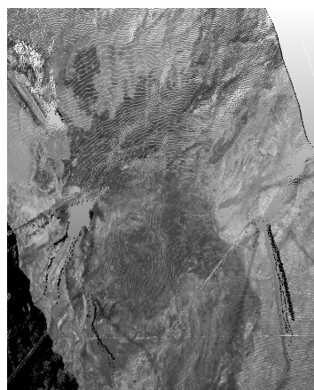
Figura 5: Un particolare della zona di crollo in galleria. Detail of a tunnel's damage zone.
