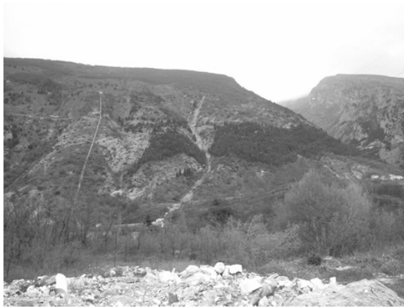
Fig. 1: Vista frontale della zona di distacco e del percorso della frana Frontal view of the landslide detachment area and path
