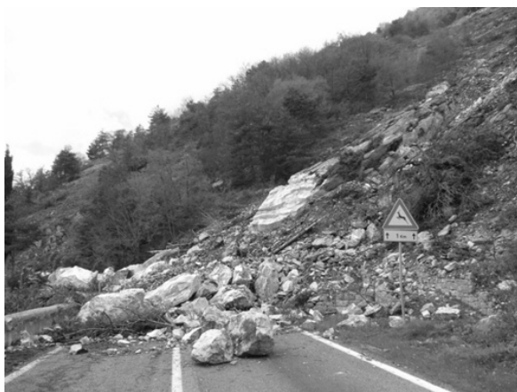
Fig. 2: Dettaglio del detrito che ha interrotto la sede stradale Detail of the boulders that caused the road interruption
