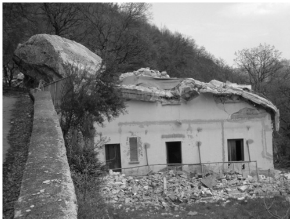
Fig. 3: Dettaglio del grande blocco (circa 400 m 3 ) che ha raggiunto il fondovalle causando la distruzione di un'abitazione privata Detail of the huge boulder (about 400 m 3 ) that reached the valley bottom and impacted on a private house
