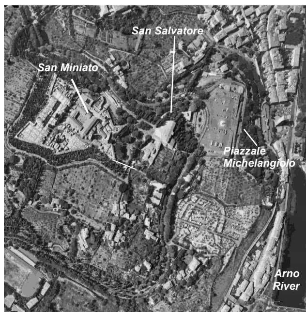
FIG. 1 – Aerial view of Monte alle Croci.
