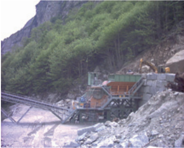
Figura 3: Impianto semimobile per la frantumazione e selezione di sfridi di cava (Val d'Ossola).
