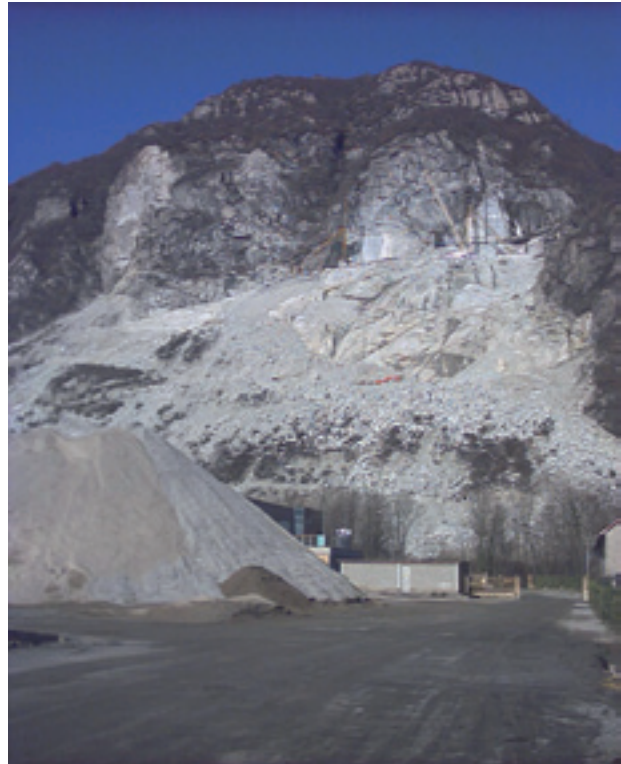
Figura 5: Discarica di cava di granito bianco di Montorfano (in secondo piano) e cumulo di prodotto in uscita dall'impianto di trattamento della Minerali Industriali (in primo piano).
