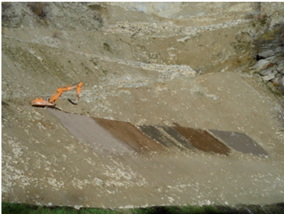
Figura 13: Spandimento dei prodotti (terriccio ricostituito) ottenuti dal trattamento di bioremediation dei fanghi filtro-pressati provenienti dal bacino estrattivo della pietra di Luserna (Dino et al., 2006). Figure 13: Spreading, on a quarry wastes slope, of products coming from the bioremediation treatment of filter-pressed sludge – Luserna Stone quarry basin (Dino et al., 2006).
