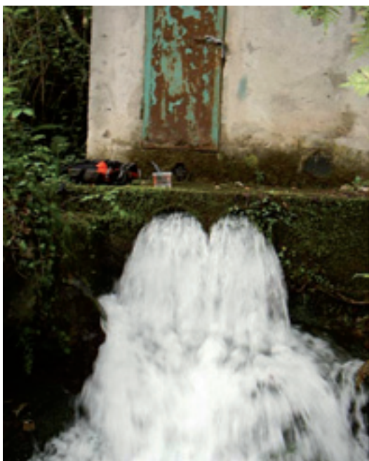
Figura 6b - La portata della sorgente in regime di piena, con l'acqua che fuoriesce dai fori di troppo pieno della vasca di raccolta (aprile '08).
