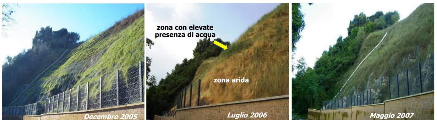
Figura 3. Da sinistra a destra: dicembre 2005; luglio 2006; maggio 2007: il cantiere della Badia sulla sp. 111 di Orvieto, realizzato su depositi piroclastici disgregati e affioramenti basaltici. La freccia gialla indica le zone con eccesso di acqua.
